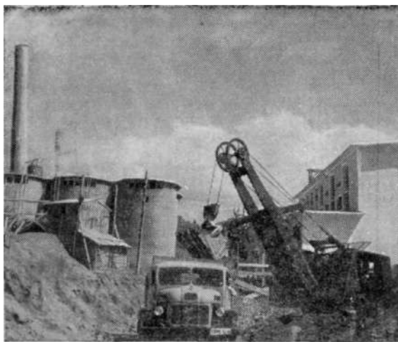
На строительстве ГЭС имени В. И. Ленина.
