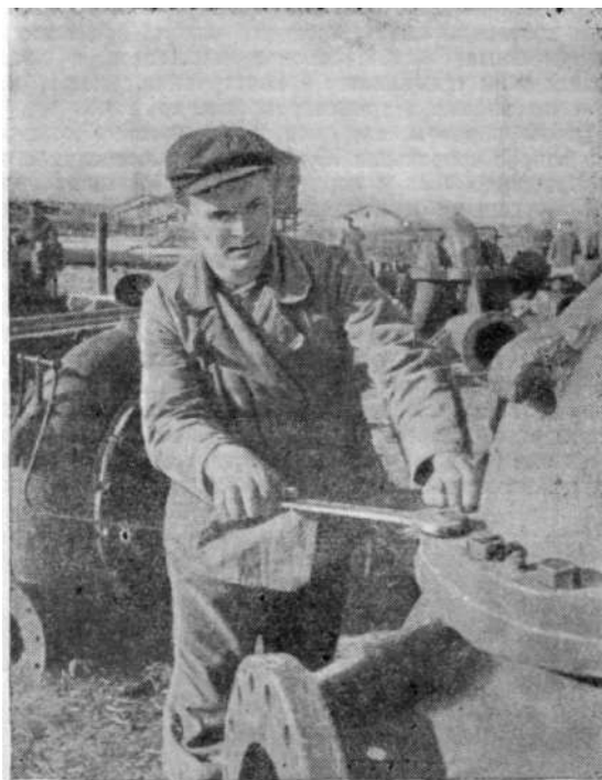
На строительстве Каховского гидроузла сооружается насосная станция открытого водоотлива для откачки воды из котлованов ГЭС и плотины. Бригада монтажников Василия Библика выполняет не менее двух с половиной норм в смену. На снимке: бригадир Василий Библик за монтажом насосной установки открытого водоотлива.
