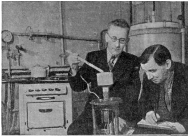
Инженеры К. Н. Правоверов и П. Н. Коновалов производят испытания газовой горелки нового типа.
